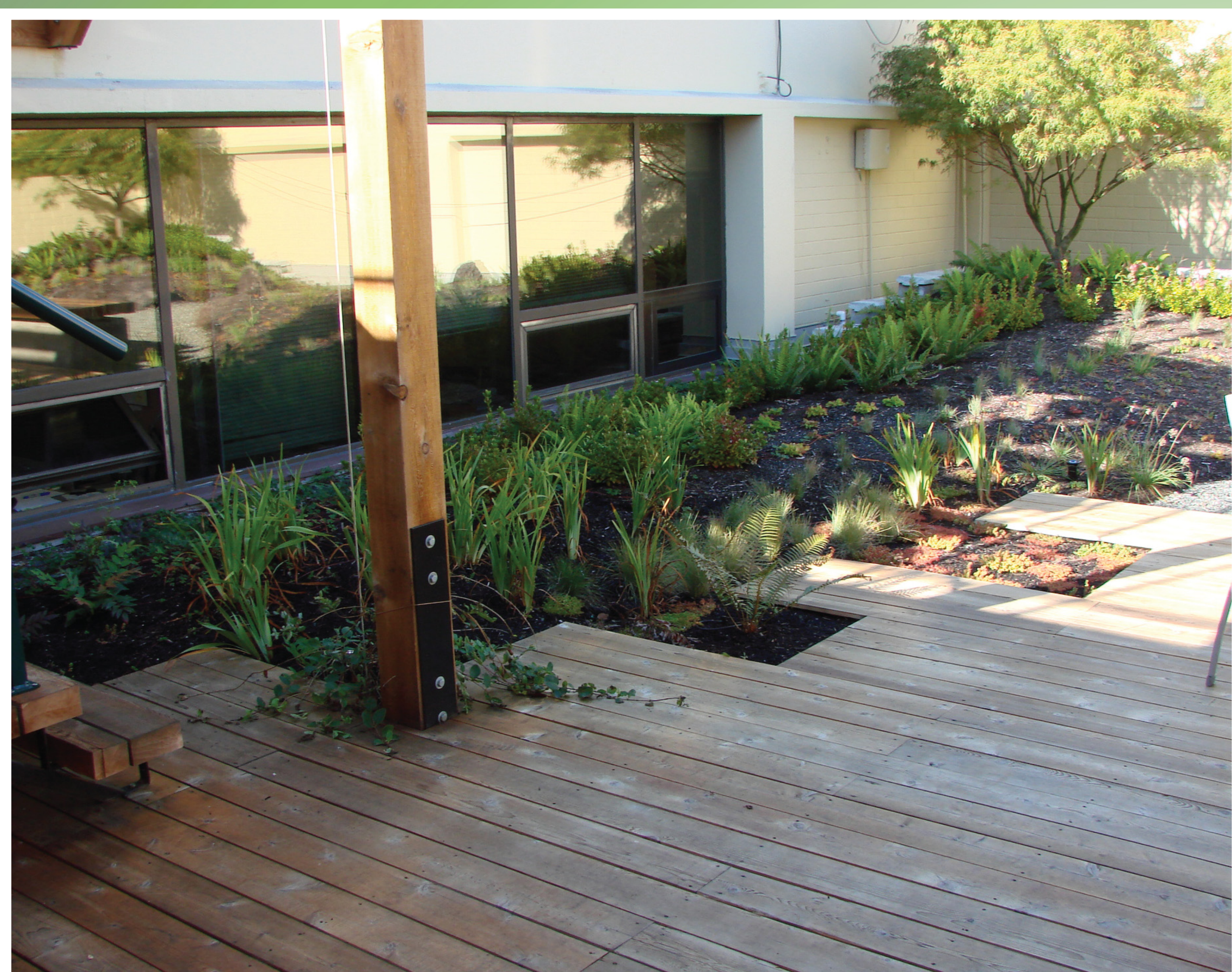
Six staff offices face onto the rooftop courtyard. / Six bureaux d'employés donnent sur la terrasse-jardin de toit.
