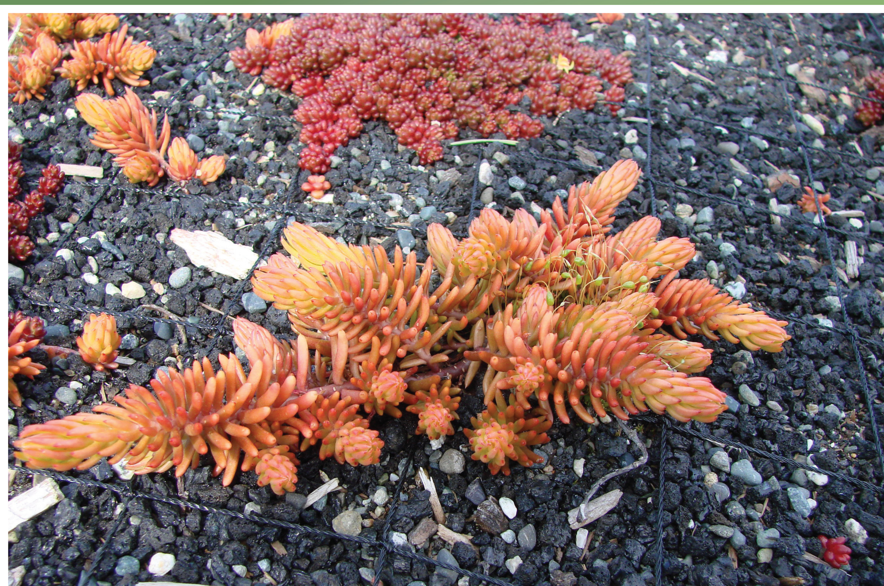
The rooftop vegetation consists of native, drought-tolerant species. / La végétation du toit se compose d'espèces indigènes résistantes à la sécheresse.
